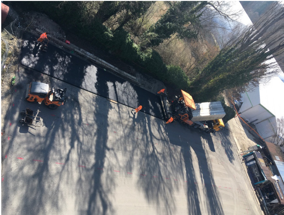
Bild 3. Bau der Rollerbahn Ende 2021
